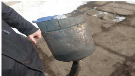
Foto nr.14 – Fisuri vechi în corpul izolatorului de tracțiune
