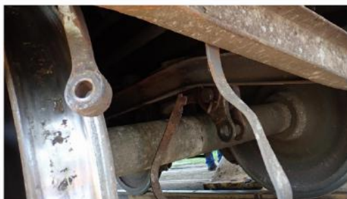
Fotografia nr.10 Etrier siguranță, rupt roata nr. 7
