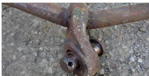
Fotografia nr.7 Conexiunea B - axa triunghiulară
