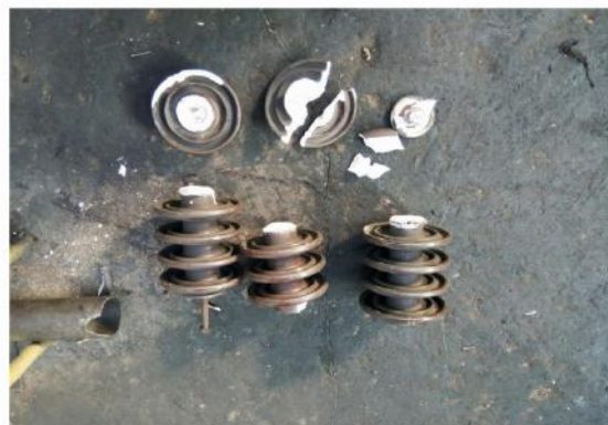
Foto nr.7 - Izolatori susținere pantograf secționați
