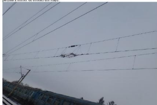
Foto nr.16 – Zona aeriană a saniei glisieră a izolatorului de secționare parțială a liniilor de contact din stație
