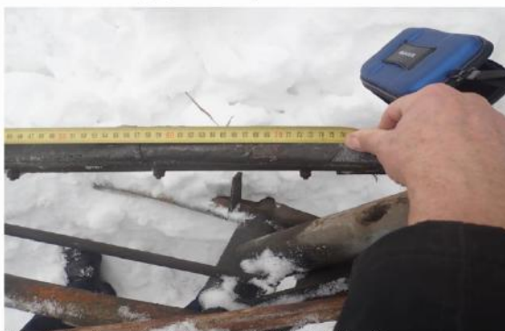
Foto nr.11 - Lungimea saniei portperii pantografului EP3 (loc. EA305) avariata
