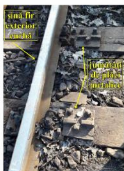
Foto nr. 2 - jumătăți de plăci metalice montate înspre exteriorul căii pe capetele traverselor
