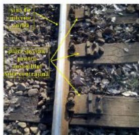
Foto nr. 1 - plăci metalice speciale pentru montarea pe firul interior al curbei a ansamblului șină-contrașină
