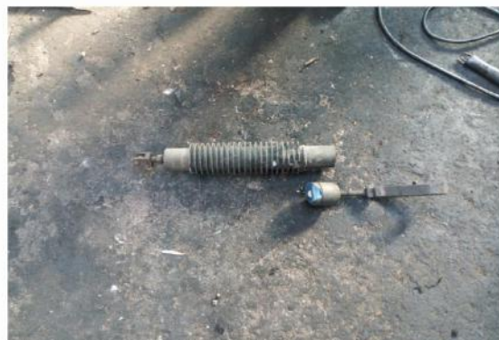
Foto nr.6 - Izolator tracțiune rupt de la cilindrul de acționare al pantografului de la postul de conducere „B” (din față, inactiv)
