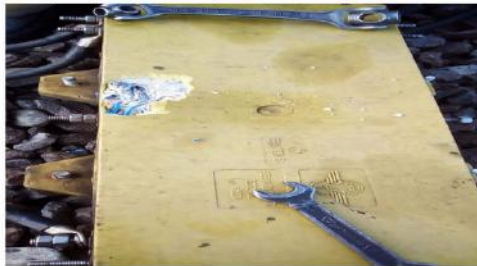
Fotografia nr.2. Bobina de joantă afectată;
